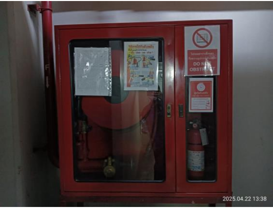
รูปที่ 3.1-20 ตู้เก็บอุปกรณ์ดับเพลิง
