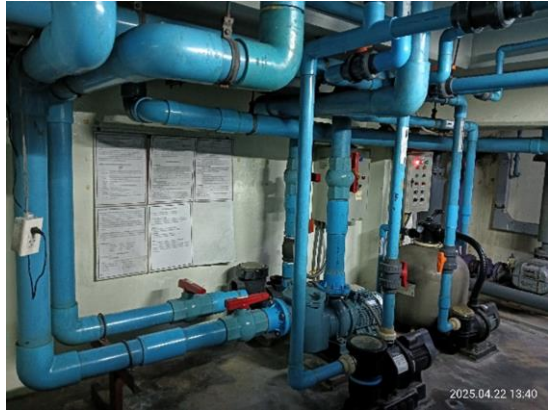
รูปที่ 3.1-5 เครื่องเติมอากาศของระบบบำบัดน้ำเสีย
