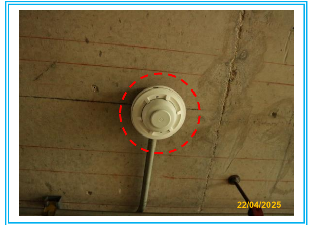
รูปที่ 3.1-25 Heat Detector
