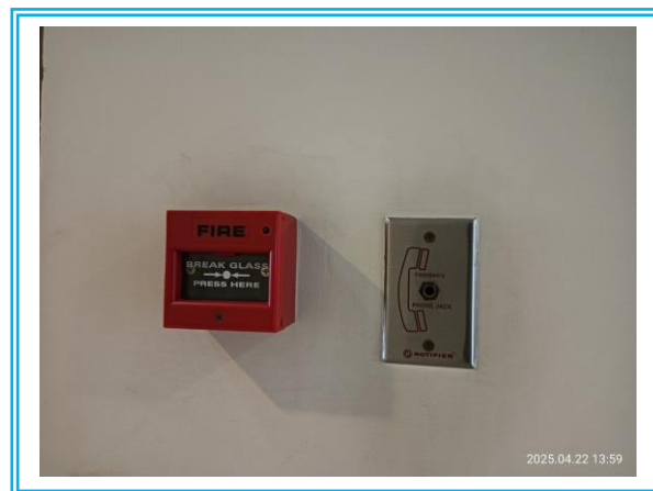
รูปที่ 3.1-26 อุปกรณ์แจ้งเหตุเพลิงไหม้ด้วยมือ แบบ Break Glass Call Point
