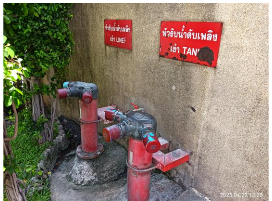
รูปที่ 3.1-23 หัวรับน้ำดับเพลิงติดตั้งภายนอกอาคาร
