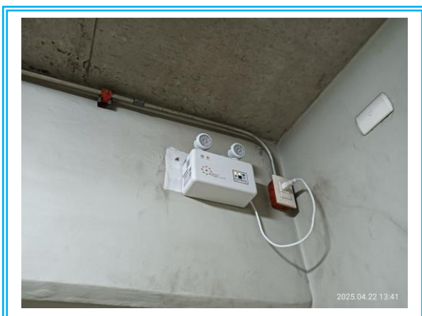
รูปที่ 3.1-32 ไฟส่องสว่างฉุกเฉิน
