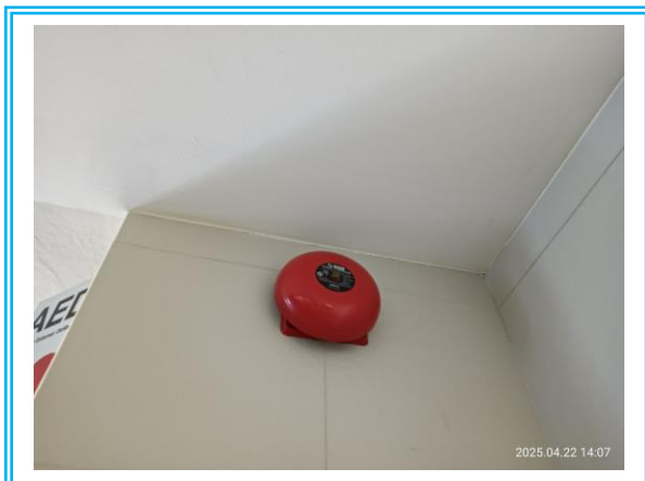
รูปที่ 3.1-30 Fire Alarm Bell
